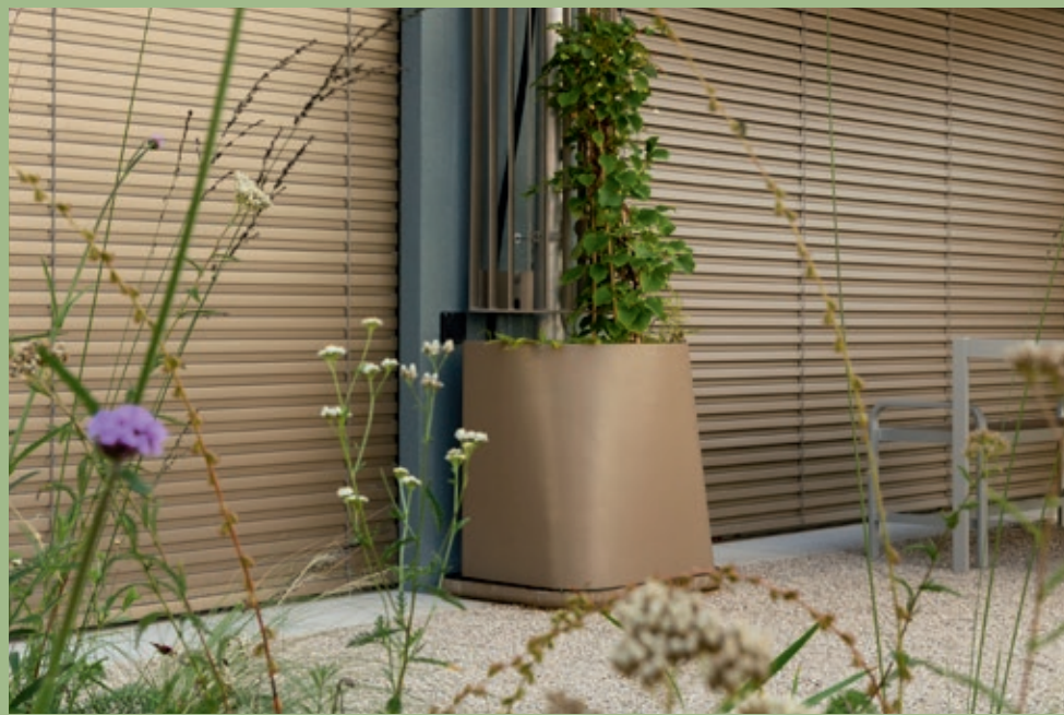
Volpatohatz Fabrication spéciale pour une façade végétalisée à Birsfelden
