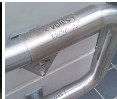
signalétique braille sur borne et sur main courante
