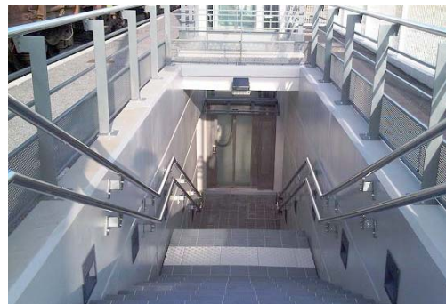
double lisse sur rampe
