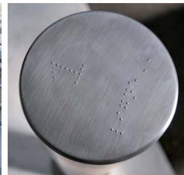
signalétique braille sur borne et sur main courante
